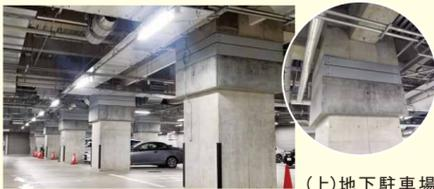
(上) 地下駐車場の柱のグレーのカバーの中に免震ゴムが設置されています。
