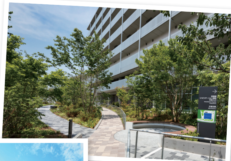
赤堤通り沿いにある緑豊かな遊歩道やベンチは地域の方に開放されています
